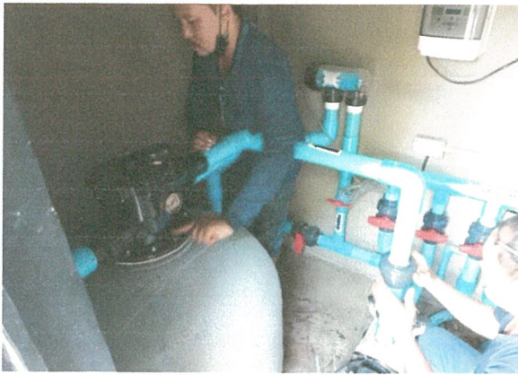
รูปภาพที่ 2.14 การตรวจสอบระบบท่อจ่ายน้ำ
